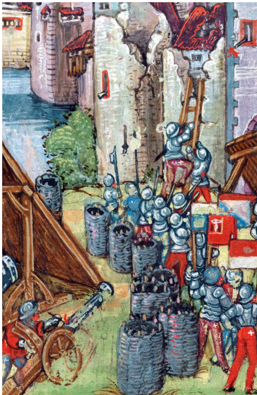
FIG. 26. Alcuni dei gabbioni impiegati dalle truppe cantonali per la difesa delle loro batterie. Riempiti di terra e sassi, questi cesti di vimini sarebbero stati introdotti in Italia già prima dello scoppio della Guerra di Ferrara.
