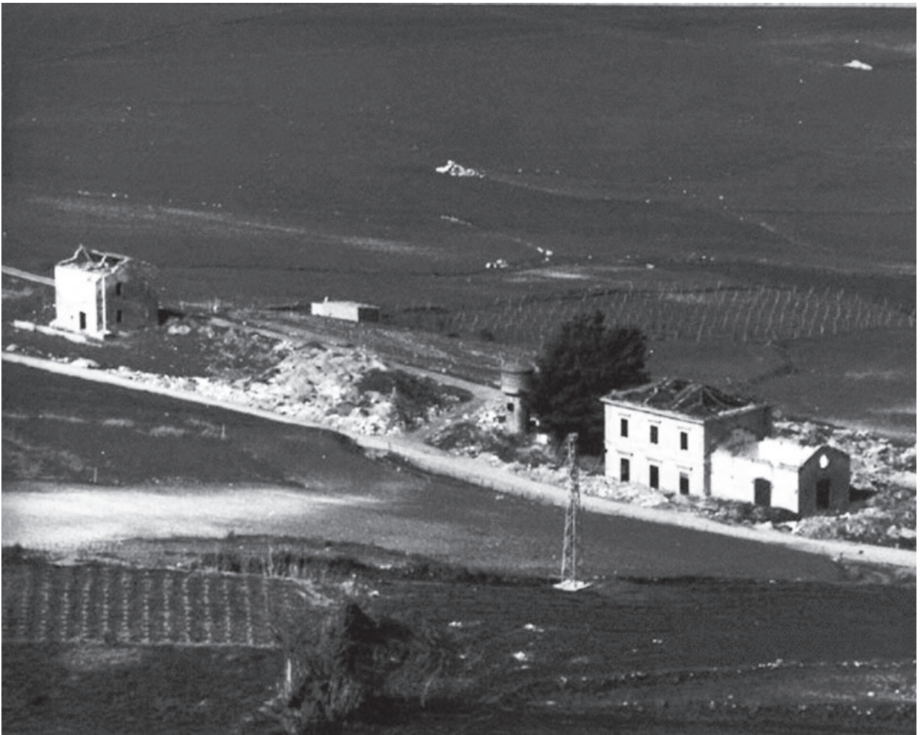
Fig. 1 - RETRACING_Giardino-Arena al Tempio, San Michele di Ganzaria, 2002-2004. Il progetto riguarda una discarica abusiva di rifiuti edili. RETRACING_Giardino-Arena al Tempio, San Michele di Ganzaria, 2002-2004. This project concerns an illegal dump of construction waste.
