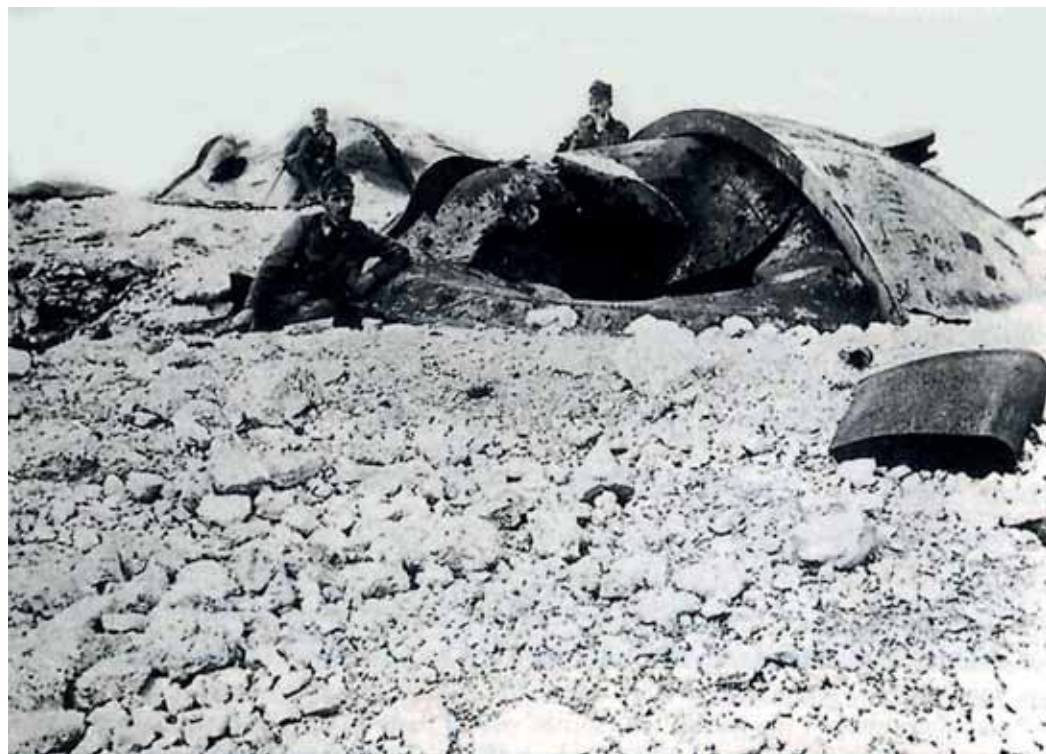
Fig. 17 – Roana, forte Verena . Le cupole italiane a guardia della Val d’Asa distrutte dal bombardamento austriaco del 12 giugno 1915 con obici Skoda da 305 mm, ritratte dopo l’occupazione austriaca del 22 maggio 1916 (da R. STRIFFLER, Von Fort Maso , cit.).
