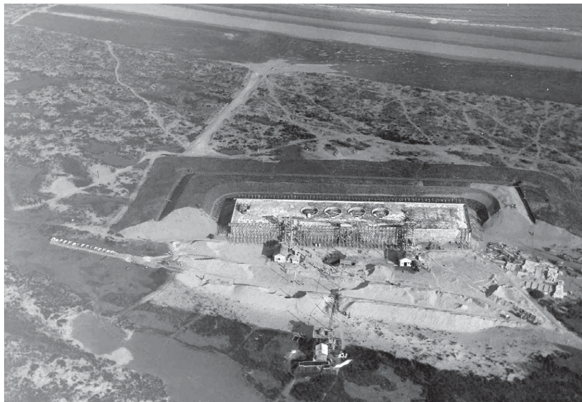
Fig. 15 – Venezia, isola di Malamocco. Forte tipo «Rocchi» in costruzione per la Regia Marina, 1915-1918 (USMM, Fototeca).
