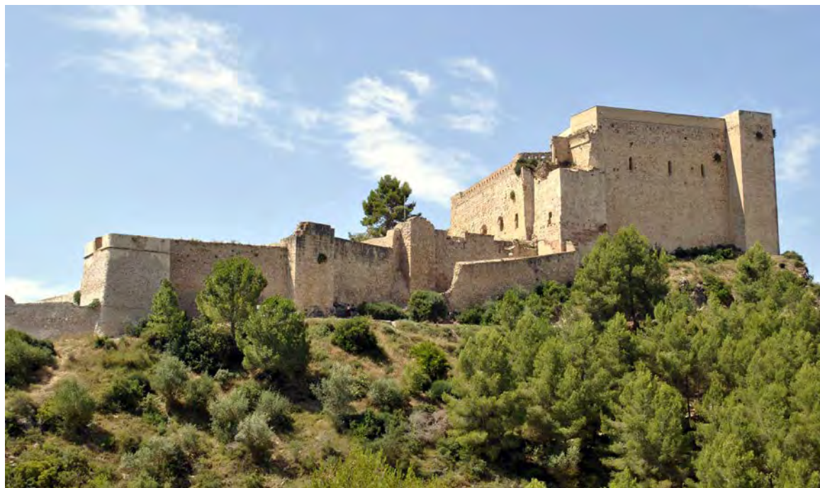
Fig. 13. Castillo de Miravet, Lado norte. Fuente: Autor
