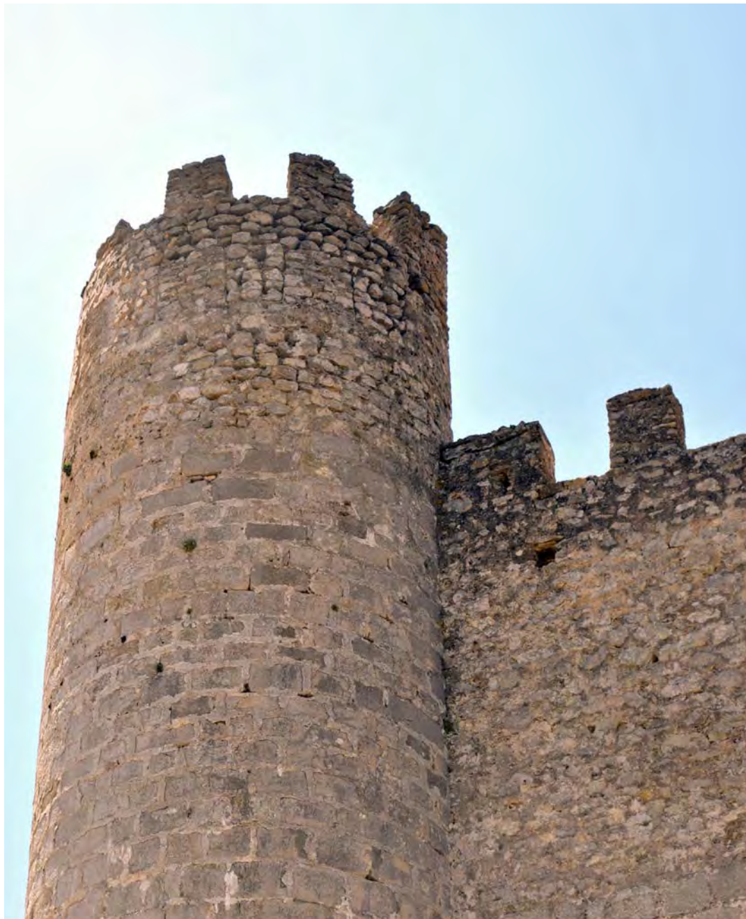
Fig. 28 Castillo de Xivert, Muralla templaria del reducto, detalle. Fuente: Autor
