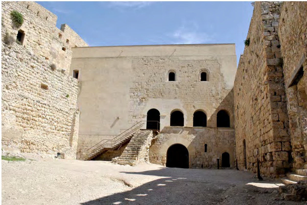
Fig. 19. Castillo de Miravet, Estructuras del lado norte del patio. Fuente: Autor
