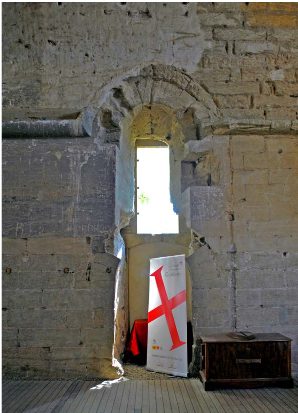
Fig. 11. Castillo de Gardeny (Lérida), Torre-residencia, Primer nivel, Saetera modificada. Fuente: Autor
