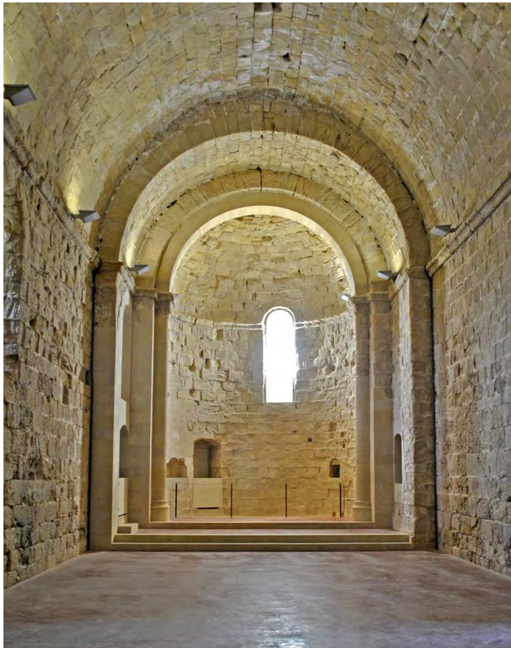
Fig. 21. Castillo de Miravet, Ábside de la capilla con su abertura descentralizada Fuente: Autor
