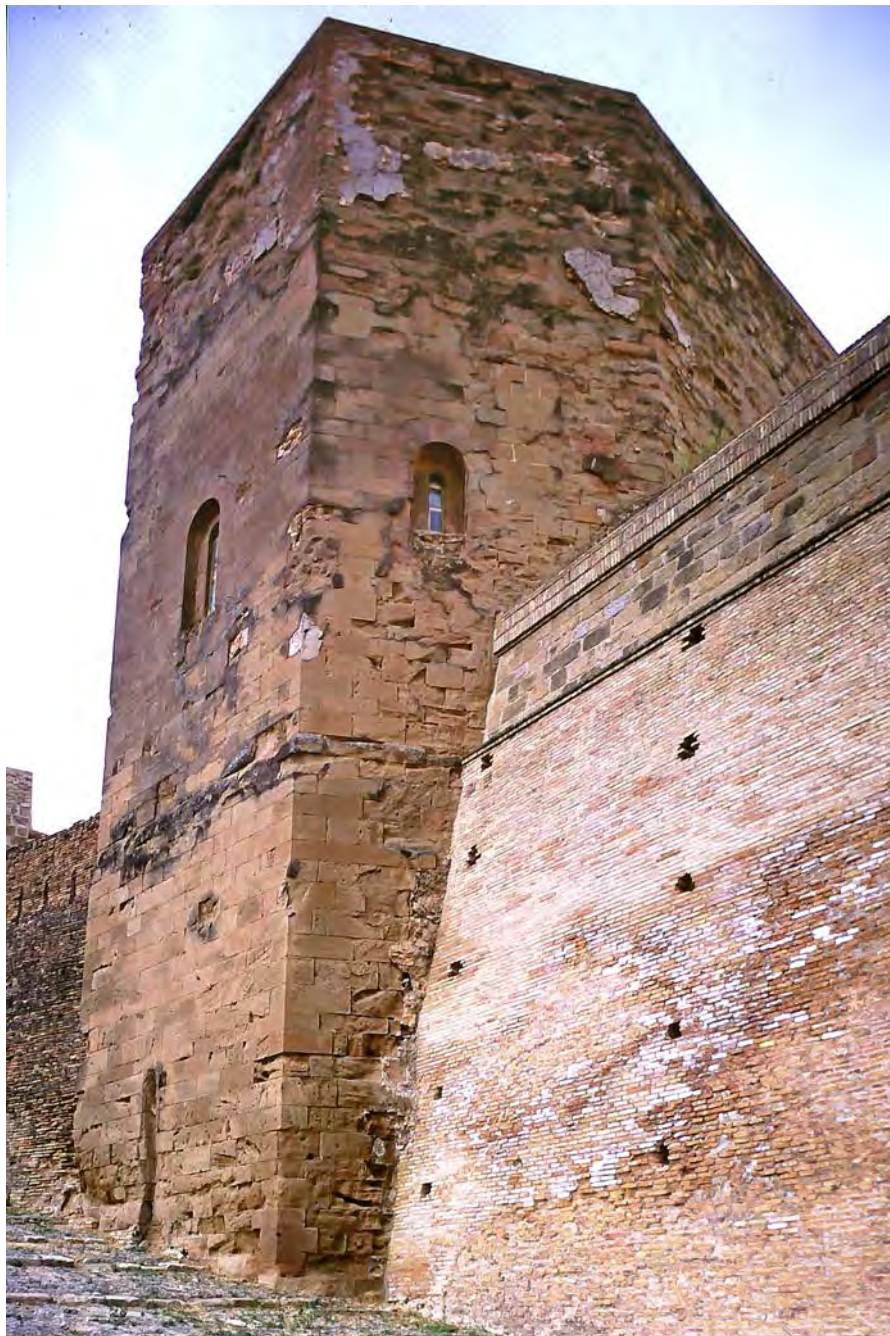
Fig. 2. Castillo de Monzón, Ábside sobresaliente de la capilla. Fuente: Archivo Cadei – Università di Roma La Sapienza
