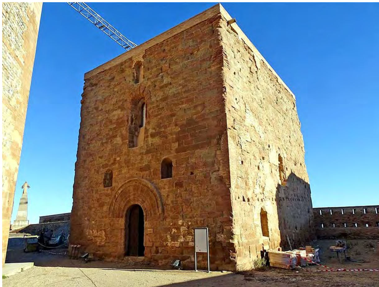
Fig. 4. Castillo de Monzón, Fachada de la Capilla. Fuente: Luis Puey Vílchez
