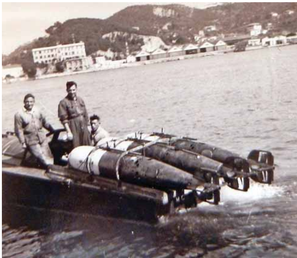
Fig. 6 – Prove di lancio di poppa da un motoscafo di 11 m di siluri da 450 mm, 1936-1940 circa (AUSMM, fondo Supermarina , serie Mezzi d'assalto , b. 1, fasc. 4).
