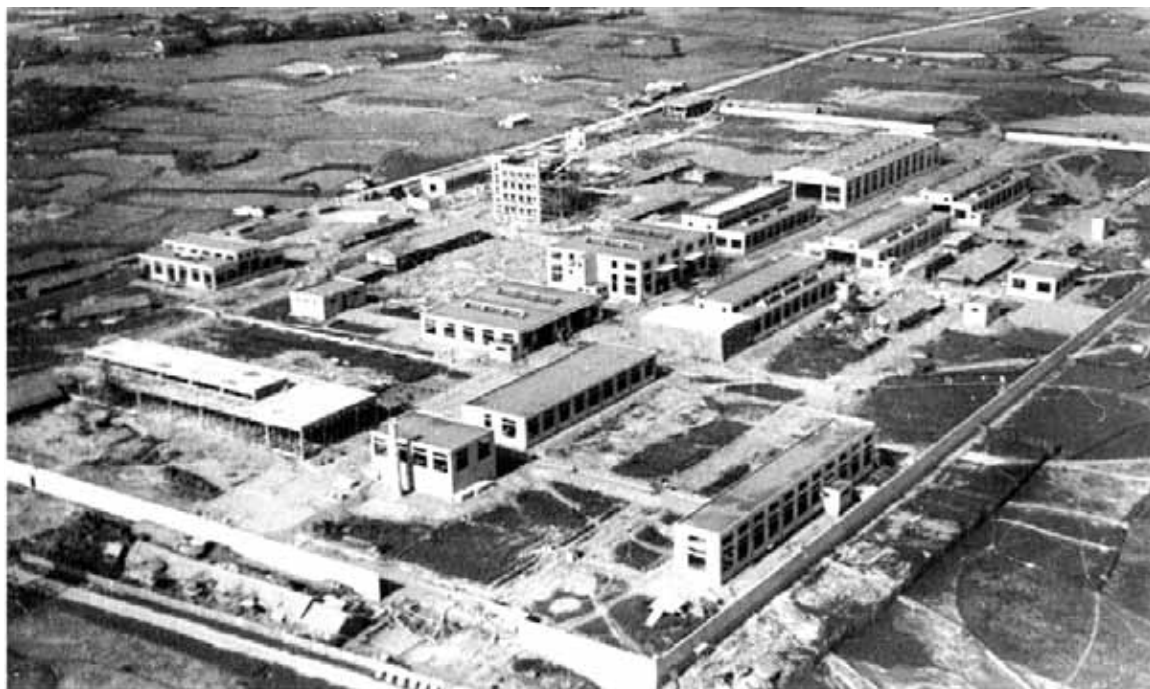
17 luglio 1936, lo stabilimento italo-cinese SINAW di Nanchang in avanzata costruzione. Entrerà in funzione a novembre
