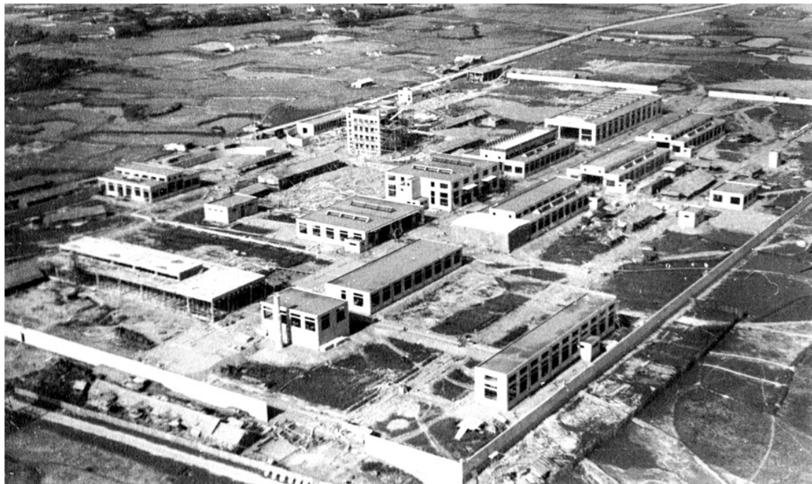
17 luglio 1936, lo stabilimento italo-cinese SINAW di Nanchang in avanzata costruzione. Entrerà in funzione a novembre
